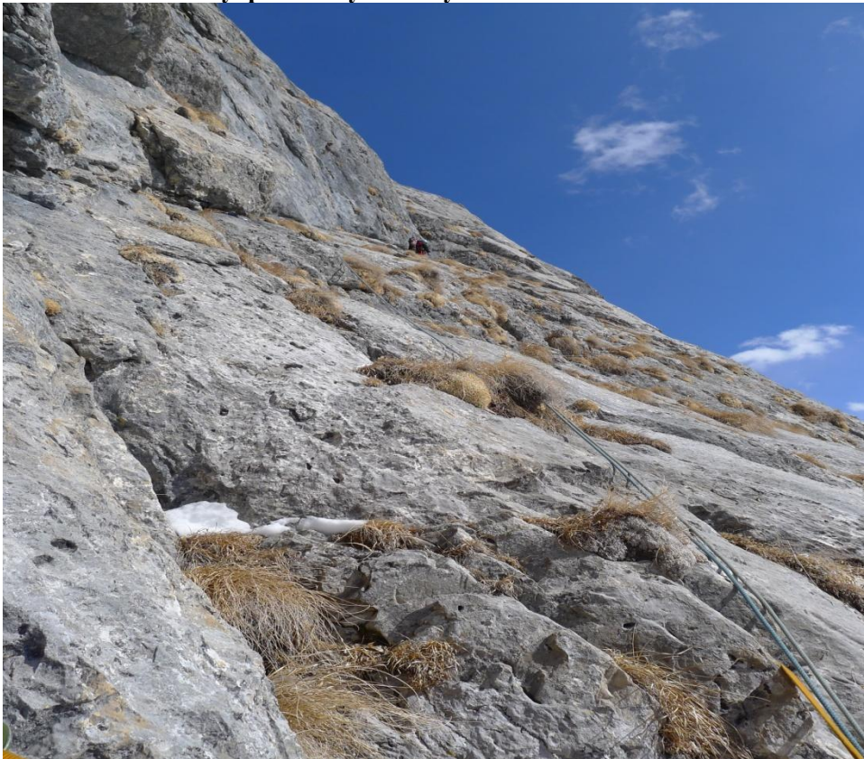
Фото 5. Работа на участке R4-R5
